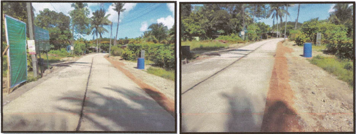
๑๐. โครงการก่อสร้างถนน คสล. สายมัสยิดบ้านเกาะนก
